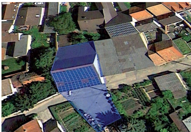
Das Gelände um den Bauhof (blau unterlegt) mit der alten Scheune aus Bruchsteinwänden und dem Platz davor.
